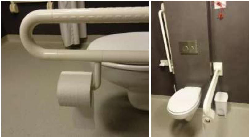
Installation des barres d'appui et dispositif porte-papier
