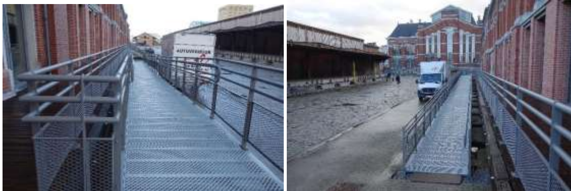
Exemple de rampe
